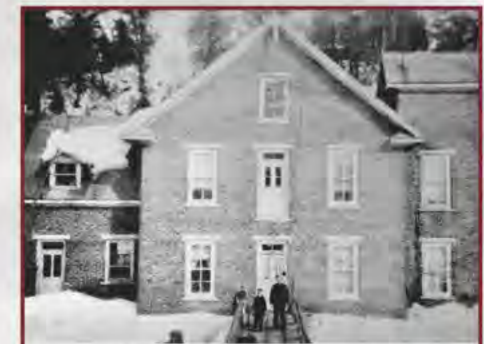
L'ancienne maison des Joubert, qui dominait l'îlot derrière le barrage, a connu bien des additions au fil des générations pour devenir une imposante demeure. Du temps de la Gatineau Power, les surveillants Raoul Whissell et Geoffrey Tassé y logeaient.
